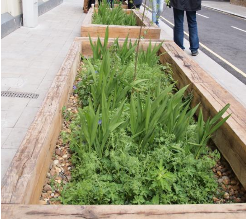
Figur 50. Exempel på utformning av regnbädd från London, Göteborg. (Fotograf Lina Engvall, KoV)
