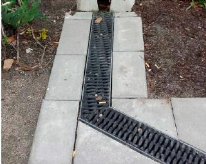
Figur 62. Täckt ränna i Örestad, Danmark (Foto: Göteborg när det regnar – en exempel- och inspirationshandbok för god dagvattenhantering – Ramboll).
