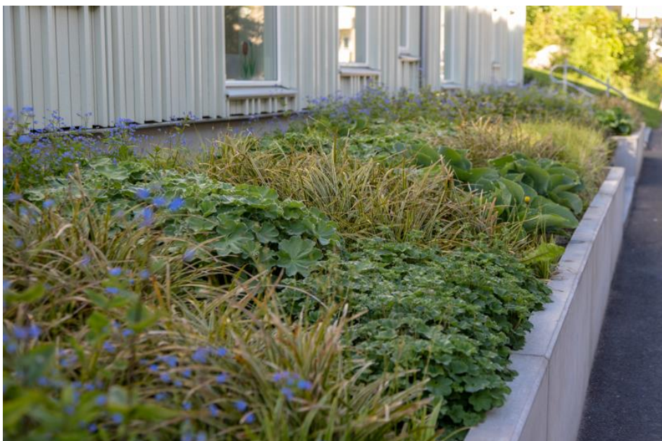
Figur 53. Regnbädd anlagd intill fasad på Sunnerviksgatans förskola. (Fotograf: Lina Ekholm, KoV)
